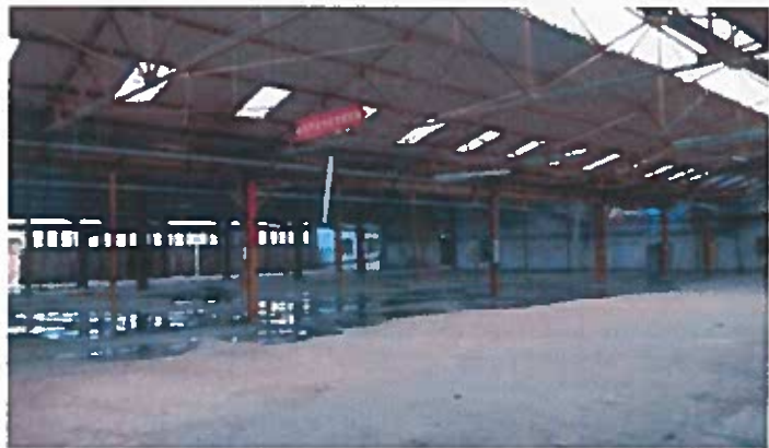
Ancienne usine Cesa - Site de la future Rockscool Marmande
