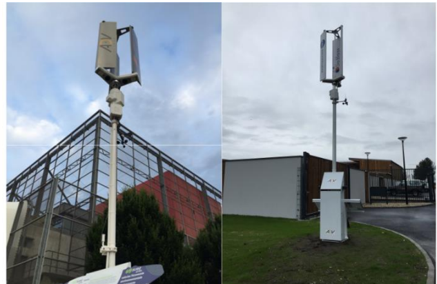
Usine SUEZ-Astria - Bègles - 2018 Siège de VEOLIA - La Teste - 2018 Installation de CityWind Mini 500 W en version préindustrielle
