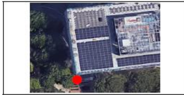
Localisation de l'aéroréfrigérant à l'angle Sud-Ouest du bâtiment côté Tramway
