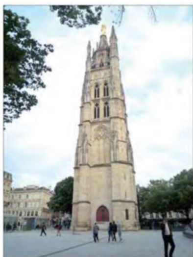
La Tour Pey-Berland, façade nord (cl. G.-H. Bailly)
